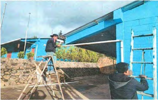
Foto 1: La bajada de agua a través de tubos de pvc en algunas partes se han caído o quebrado por lo que se esta sustituyendo con un avance del 60%.
