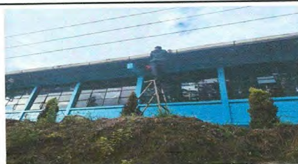
Foto 6: Todas las aulas tienen recoleccion de aguas a través de canaletas de pvc pero en algunas partes se han quebrado o caido por lo que se estan sustituyendo con canales nuevos con un avance del 60%
