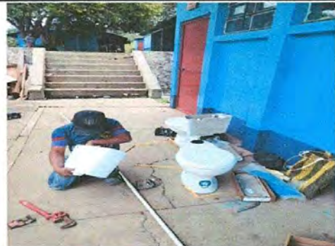
Foto 4: Actualmente se estan instalando tres baños lavables con un avance del 60%.
