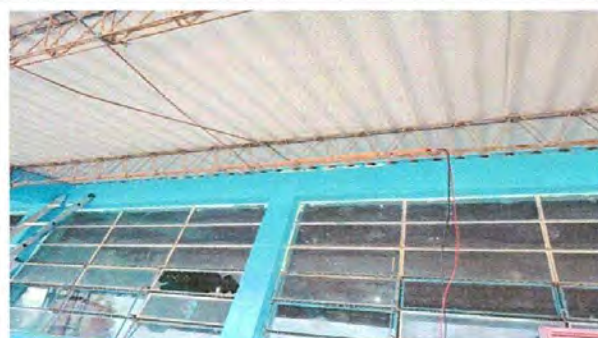
Foto 4: Hay una parte de las aulas donde hubo un corte circuito y no llega electricidad en dos aulas por lo que se esta cambiando el cable con un avance del 60%.
