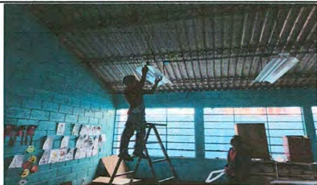
Foto1: En algunas aulas las lamparas se han quemado por lo que se estan sustituyendo con un avance del 60%.
