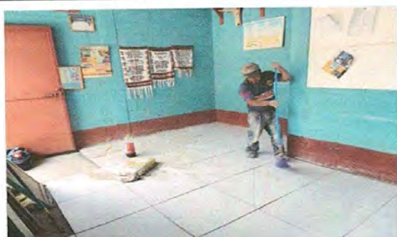
Foto 5: Este es la dirección del centro educativo y su piso era de torta de concreto pero se está sustituyendo por piso de cerámica, con un avance del 80%.
