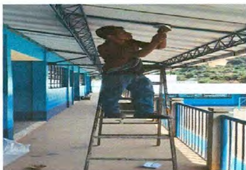
Foto 3: Muchas plafoneras se han roto o quemado se estan sustituyendo con un avance del 60%.
