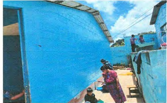
Foto 2: Todas las paredes han estado des pintadas, por lo que se está pindo con una avance del 60%.
