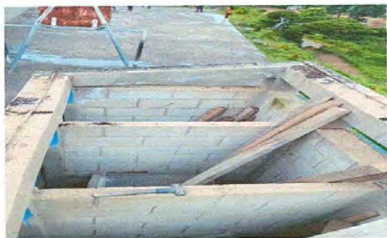
Foto 1: Este modulo de baños es de letrina se reactivarán para baños lavables pero se está sustituyendo el techo, el avance va en un 50%.
