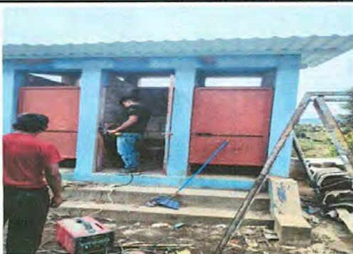
Foto 3: Estas puertas de baños se estan pintando de nuevo con un avance del 60%.
